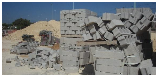
Rotura de material por acopio indebido
